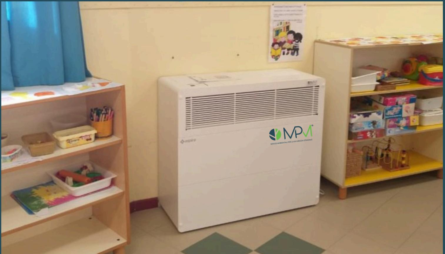
PER LE **NUOVE COSTRUZIONI** O RISTRUTTURAZIONI "IMPORTANTI" È DA PREDILIGERE UN **SISTEMA CENTRALIZZATO** CON CANALIZZAZIONE INTEGRATO IN **UTA** (UNITÀ TRATTAMENTO ARIA). INVECE IN **EDIFICI ESISTENTI/STORICI** E DOVE SI VUOLE LIMITARE LA PORTATA DELL'INTERVENTO È PREFERIBILE OPTARE UN **SISTEMA DECENTRALIZZATO CON RECUPERATORE DI CALORE INTEGRATO**.
